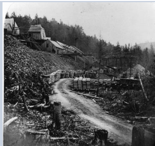
Chantier de la mine Huntington en 1867
