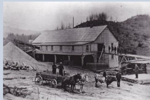
Moulin St-Pierre à South Bolton
